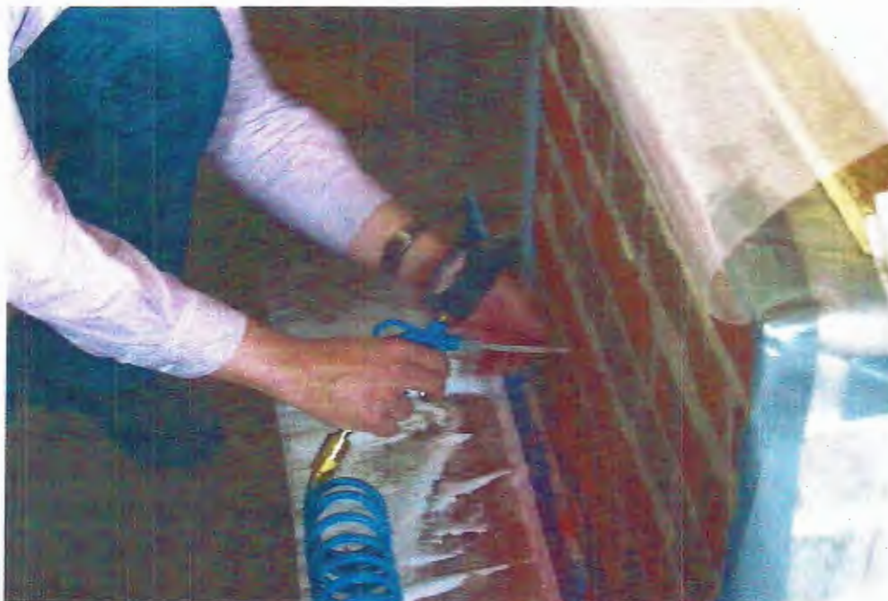
Bild 2 Ausblasen der Bohrlöcher
