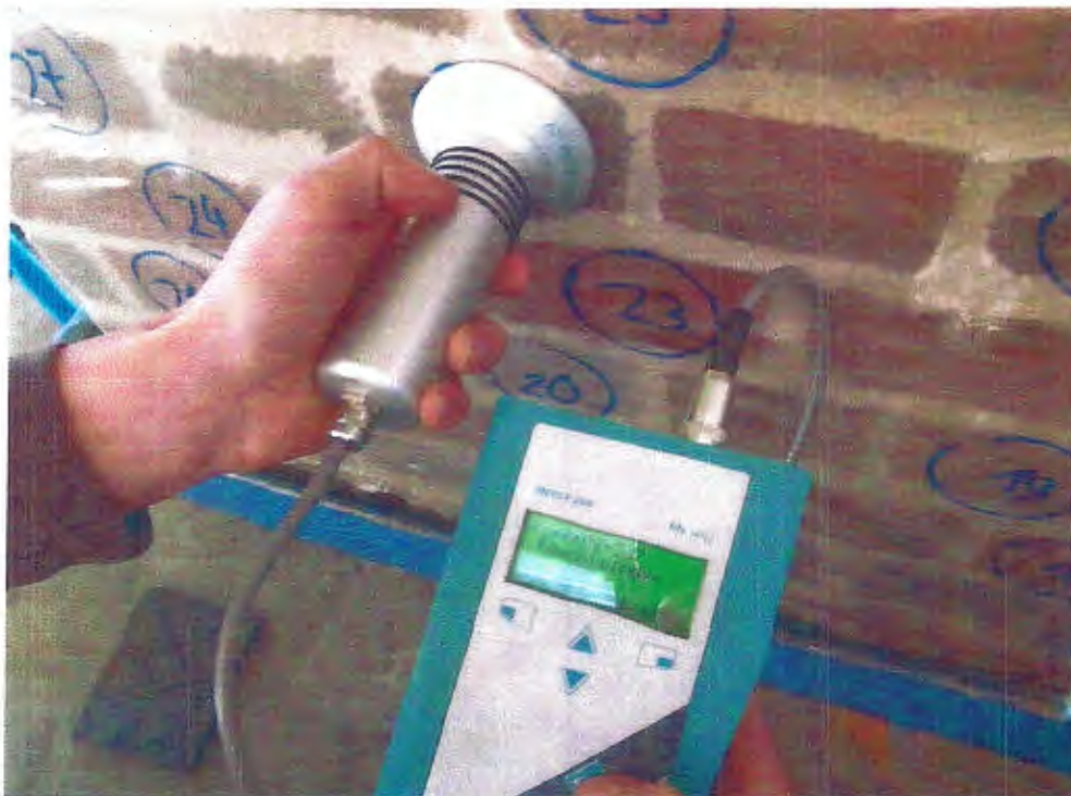
Bild 4 Messprinzip Feuchtemessungen mit Mikrowellenfeuchtemessgerät
