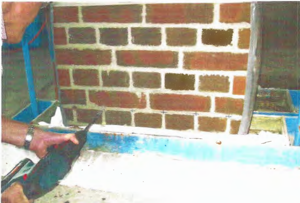
Bild 1 Anlegen der Bohrungen
